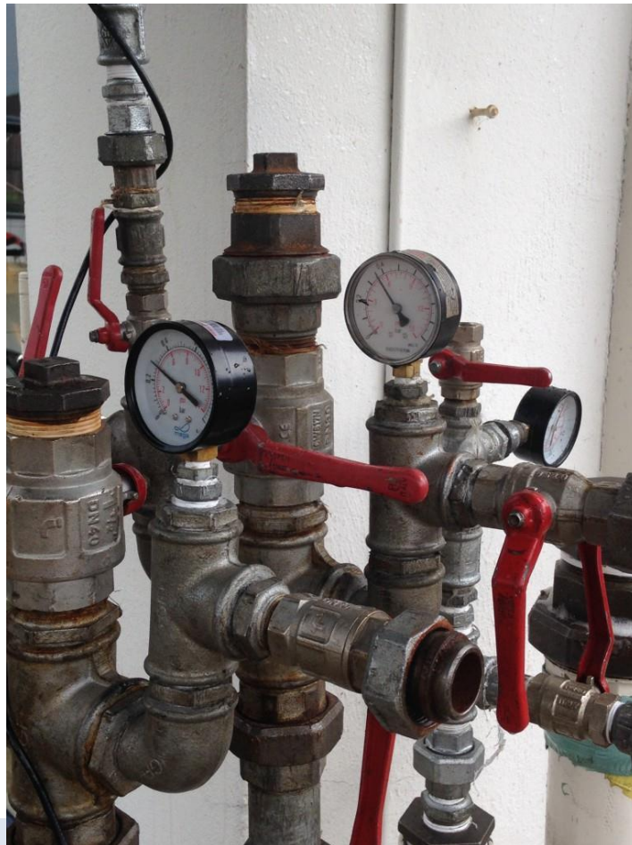
Foto 15: Op dichtheid te beproeven installatie.
