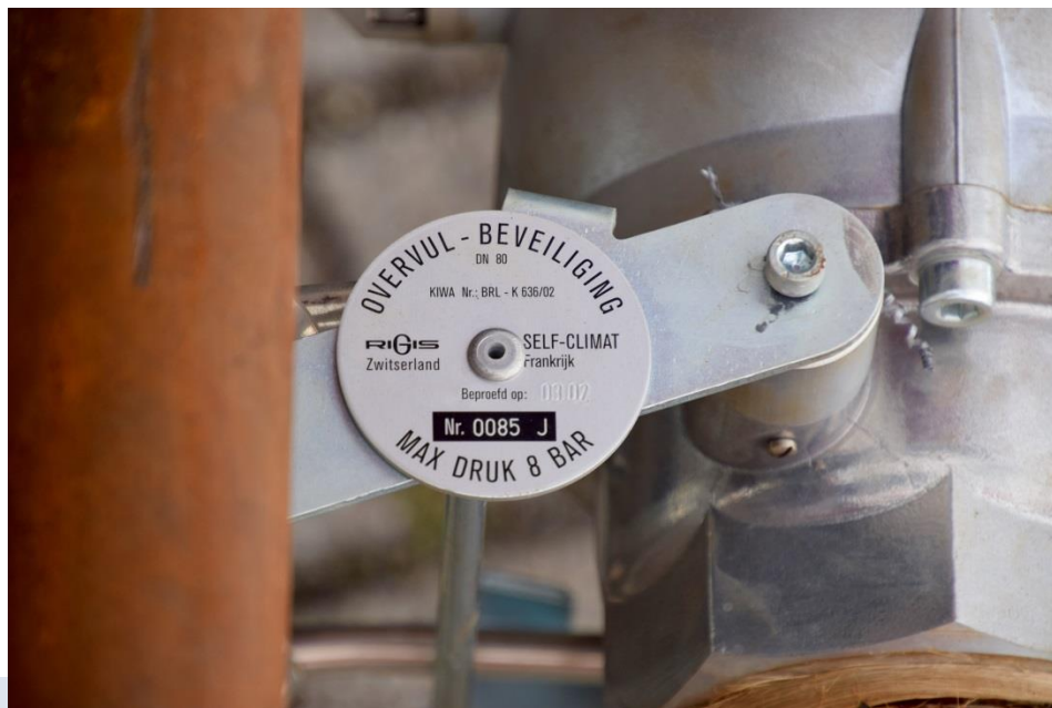
Foto 9: Overvulbeveiliging
